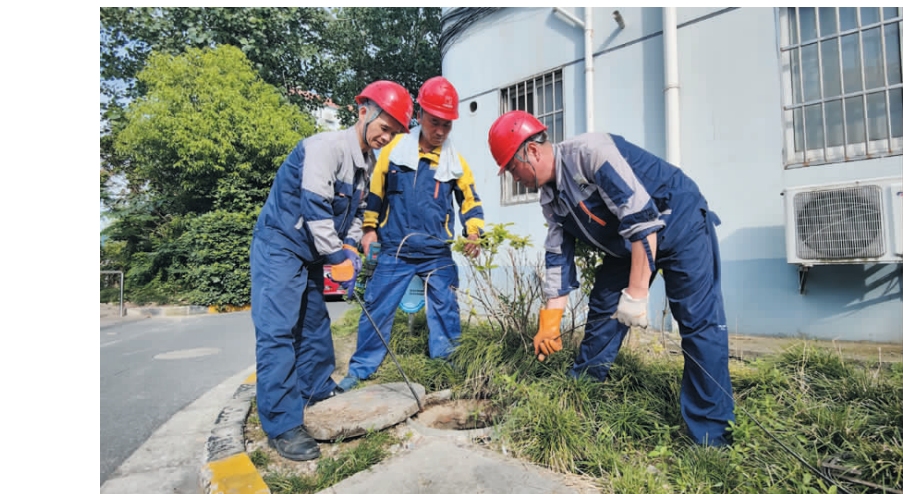
▲光明国际轻工物业员工无惧高温，奔走在社区中，为居民处理水电维修、解决管道堵塞等问题。
