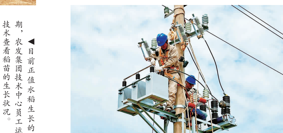
▲上海农场辖区电网面临严峻“烤”验，为保证辖区电网安全稳定运行，电力组员工开展隐患排查整治工作。
